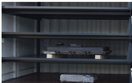
4 compartimentos para baterías no críticas
